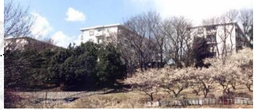
中層分譲街区 (2-2)
