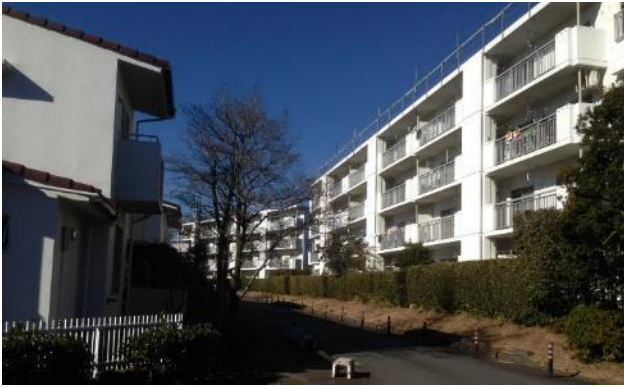
写真－UR 賃貸住宅（1-10 街区）
