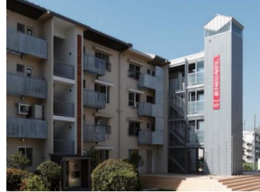
階段室住棟のエレベーター設置例 (写真：UR都市機構提供)
