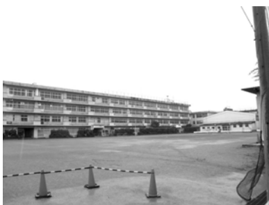
③ 本町田中学校 敷地面積：15,592 m 2
