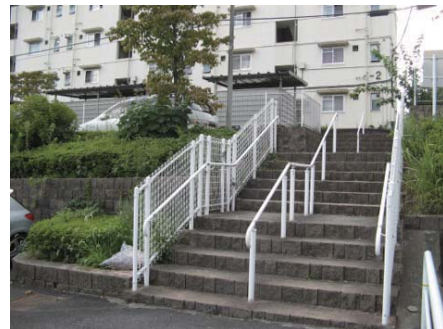
団地内の階段 (バリアフリー対策が必要)
