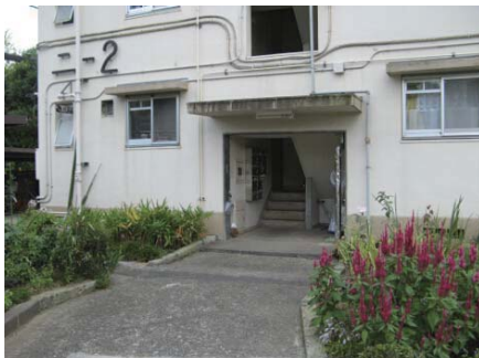
5階建てでエレベータの無い住宅棟
