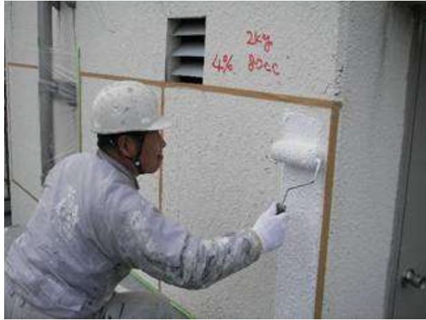
外壁塗装の試験塗り
