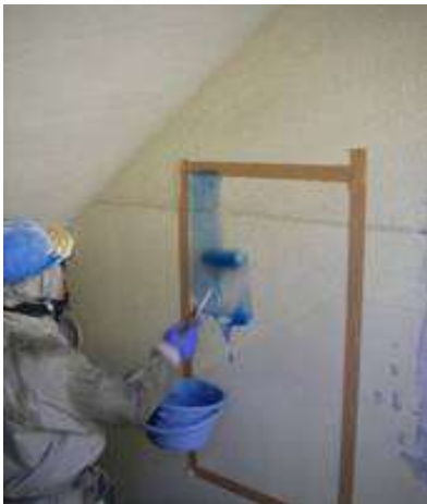
剥離剤とケレン棒による塗膜除去作業
