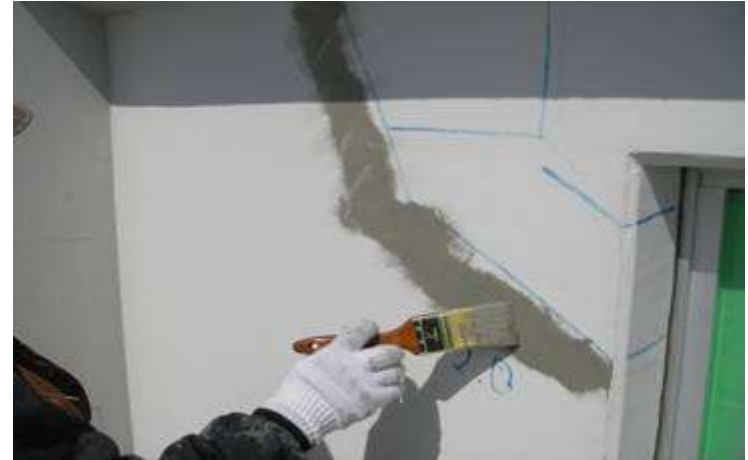
軽微なひび割れのフィラー処理
