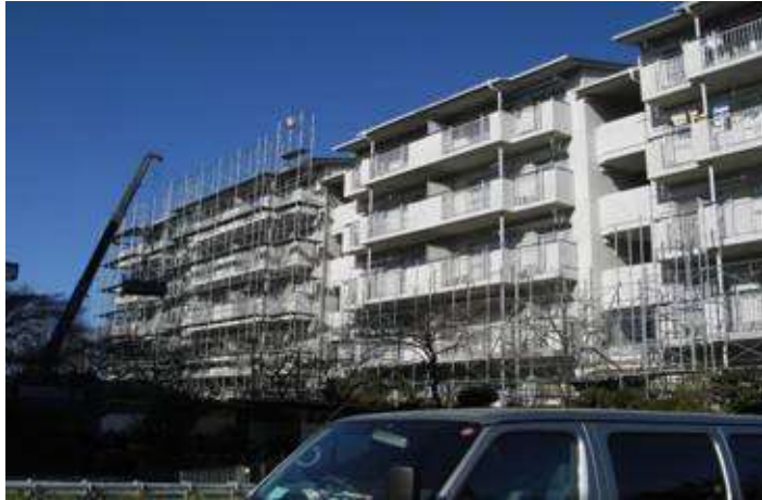
仮設枠組み足場の組み立て
