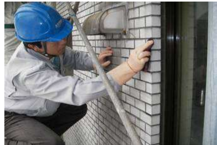
専用薬剤によるタイルのクリーニング
