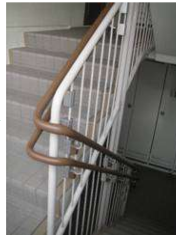
スチール製手摺の交換 (アルミ製手摺へ)
