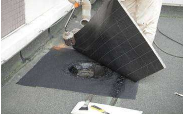
改質アスファルトシート防水の補修（トーチ工法）
