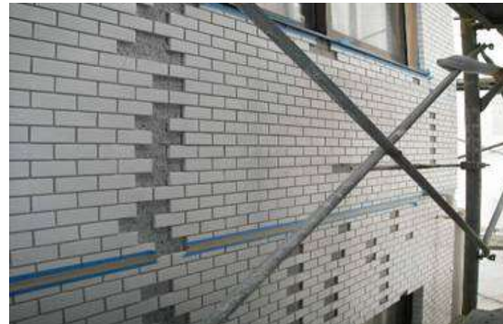
磁器質タイルの張替え補修
