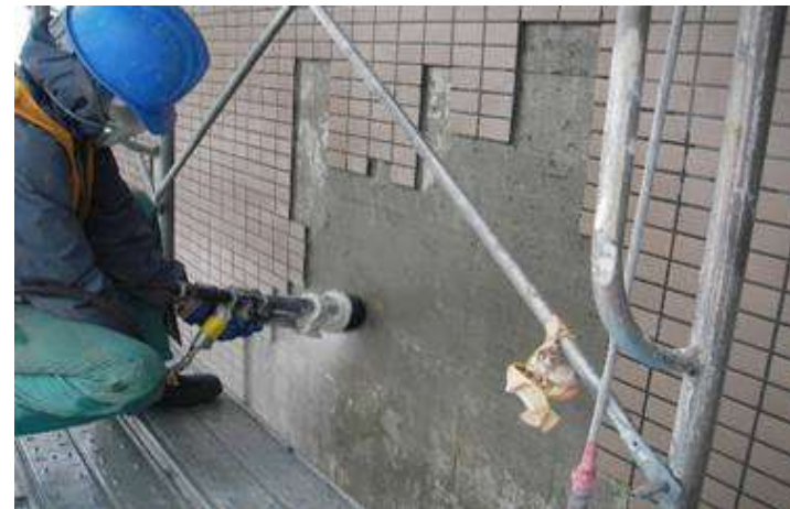
下地コンクリート表面の超高压水による目荒し
