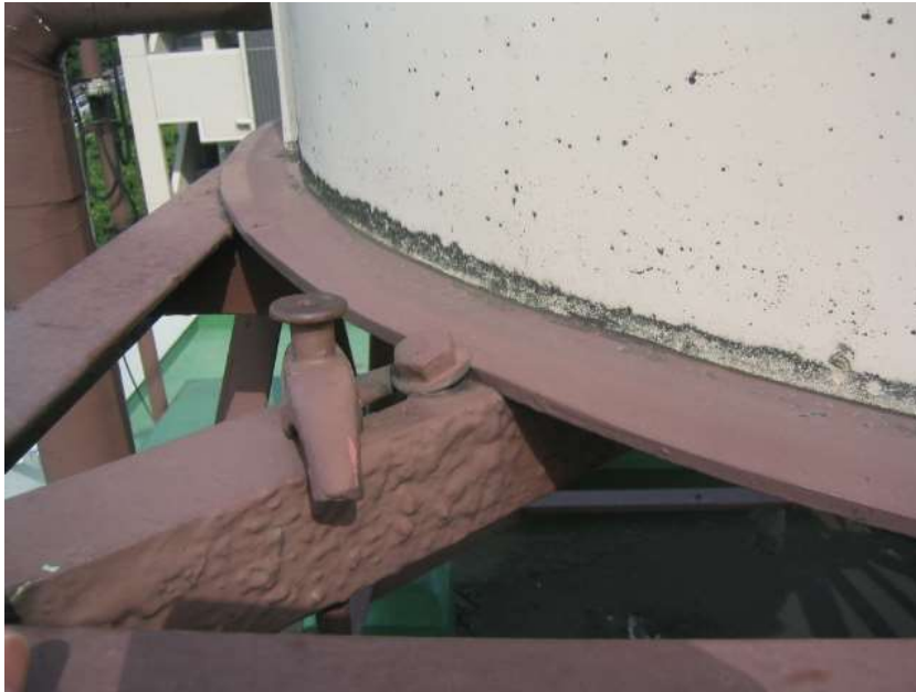
耐震性能の低い高置水槽の設置例
