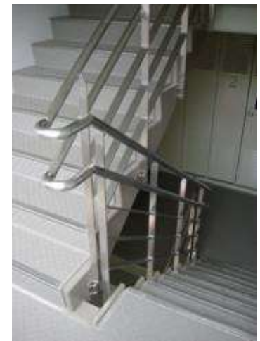
スチール製手摺の交換 (アルミ製手摺へ)
