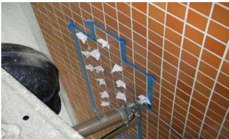
タイル浮き部のエポキシ樹脂注入処理
