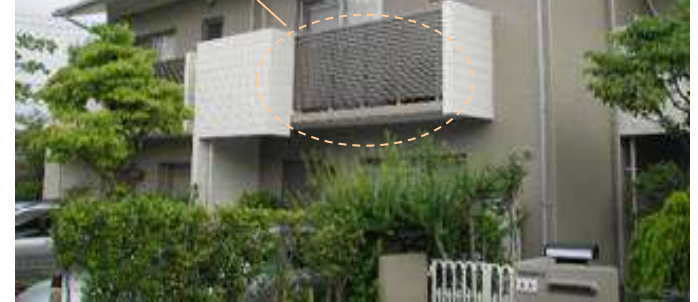
スチール製手摺の交換 (アルミ製手摺へ)
