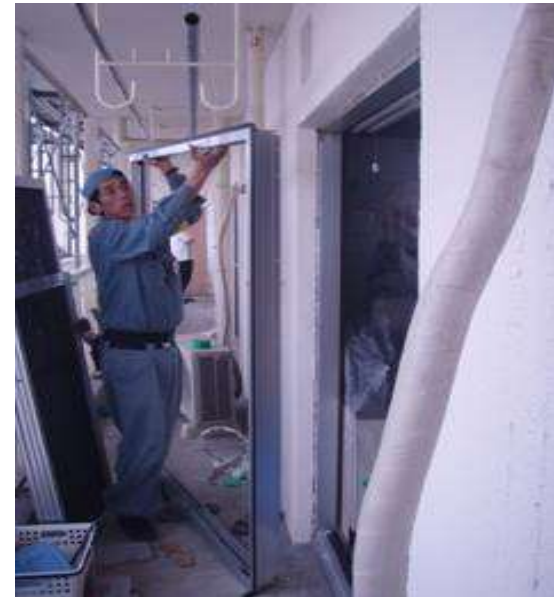
アルミサッシの交換（カバー工法）
