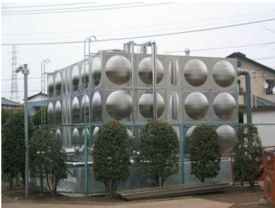
FRP製からSUS製に交換された屋外受水槽
