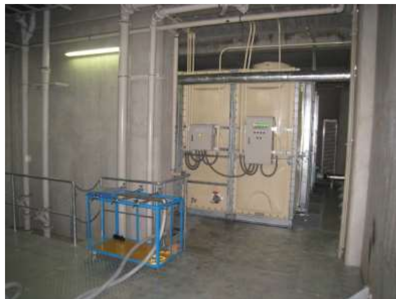
大震災時に供給を遮断し水を確保する装置と、取水装置を設置した例
