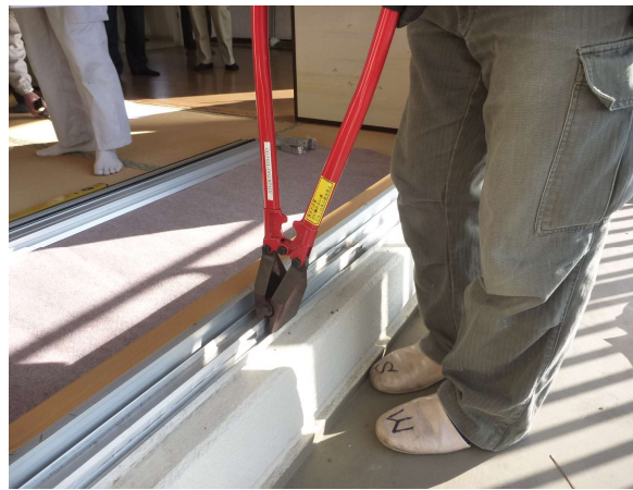
下枠レールカット
