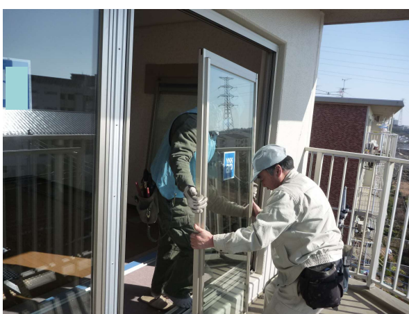
新規障子建て込み
