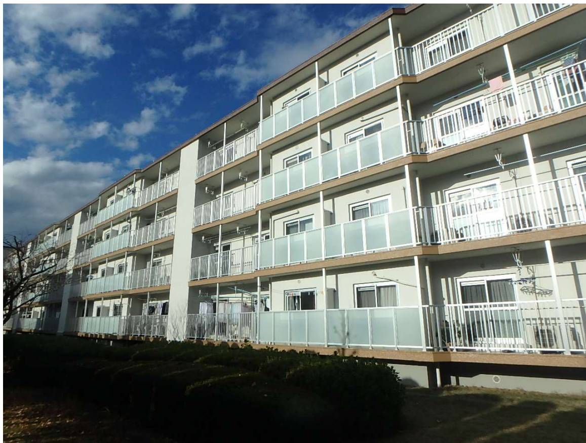
新規アルミ手すり金物（全体外観）
