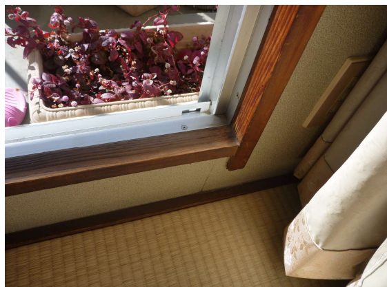
既存窓の木枠
