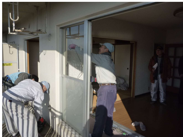
旧サッシ障子取り外し
