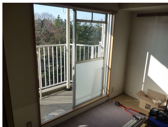
旧アルミサッシ （中棧付き・下部すりガラス）
