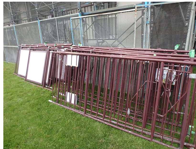
鋼製手すり金物撤去部材
