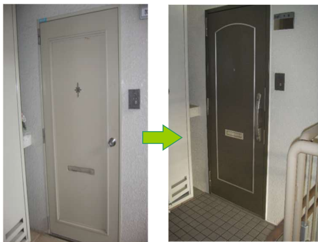
玄関扉の更新
