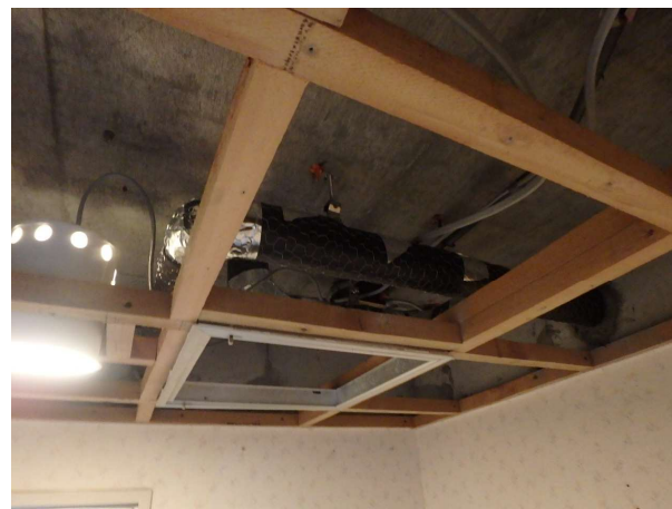
排水管取替えのための室内天井解体
