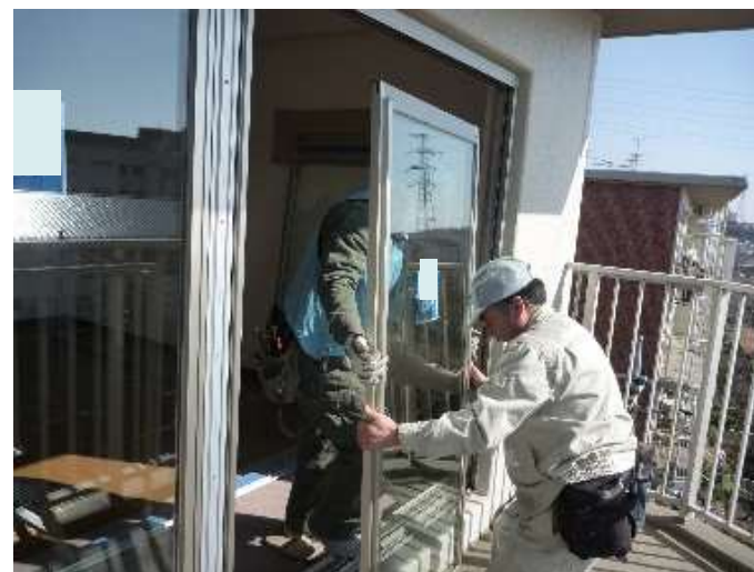
枠カバー工法によるサッシの更新
