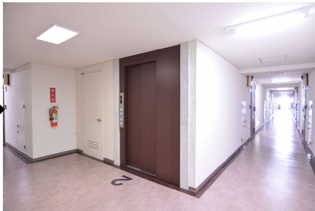
改修後（床仕上げ材張替え、ELV扉化粧フィルム、壁・天井・その他塗装）
