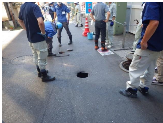
(左)道路陥没・(右)復旧作業
