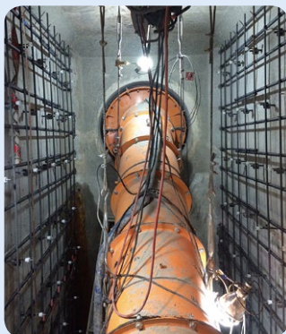
▲マンホールの耐震化工事の様子。内壁を補強しています。
