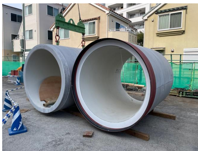
図 6-9 浸水対策として行う雨水管整備工事
