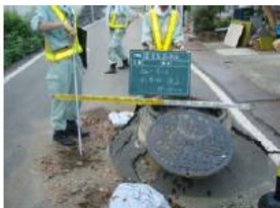
図 6-18 液状化によるマンホール浮上状況
