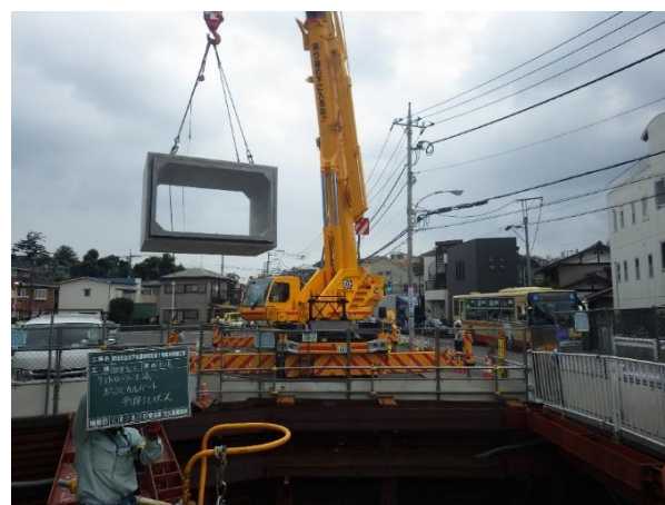
(大型ボックスカルバート:内寸 2500mm×1500mm)
