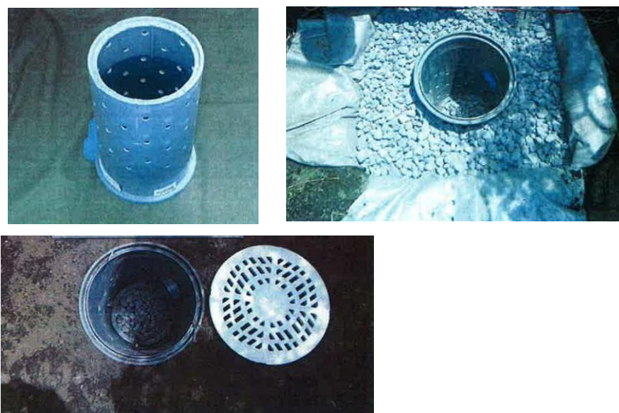
図6-10 雨水浸透設備
