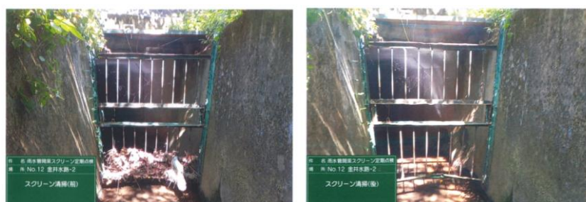
図 6-11 事前点検パトロールによるスクリーン清掃前後
