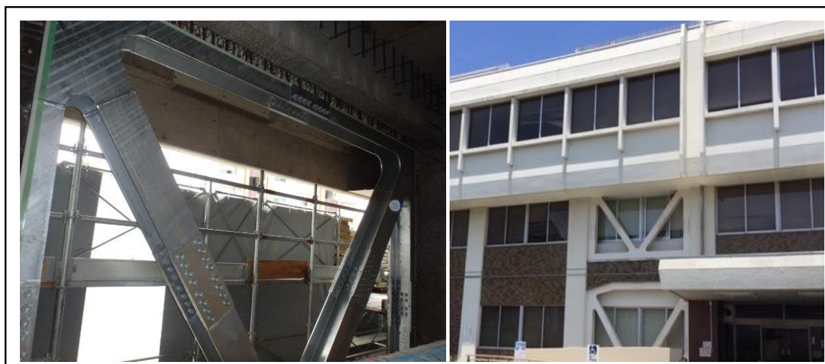
図6-21 耐震補強工事中の建物(写真左)及び耐震化工事完了後の建物(写真右)
