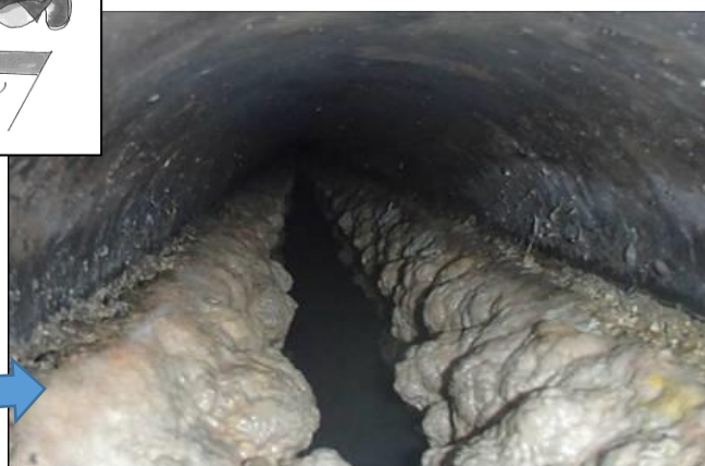
図 6-4 油脂がたまった下水道管の内部
