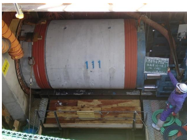
(大口径推進管:内径 2000mm)
