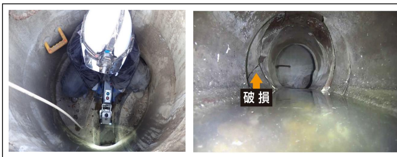
図 6-26 スクリーニング調査の状況(写真左)及び破損状況のイメージ(写真右)
