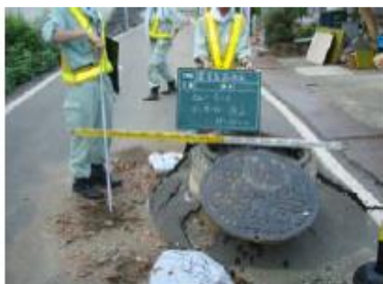
図 6-18 液状化によるマンホール浮上状況
