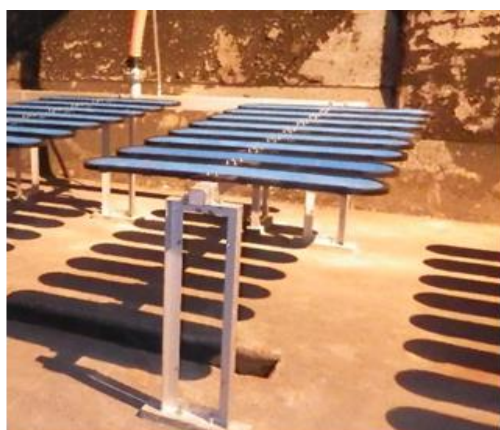
図 6-5 成瀬クリーンセンターの高効率散気装置
