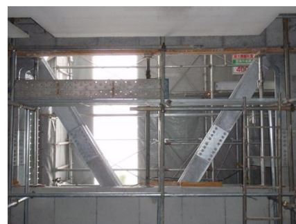
図8. 耐震ブレス補強
