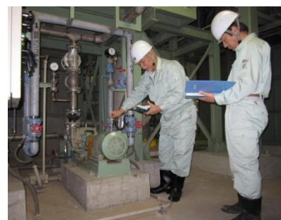
図 10. 施設点検の様子
