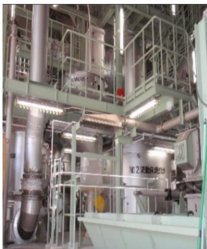
図3 高温焼却対応型焼却炉
