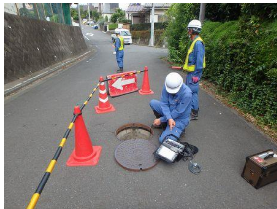
図8 点検・調査状況
