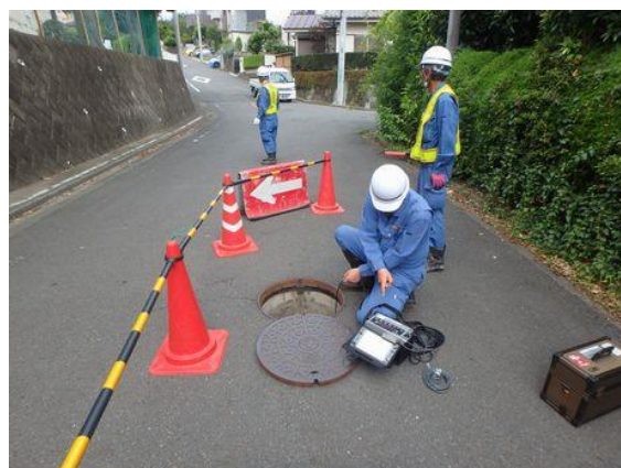
図8 点検・調査状況
