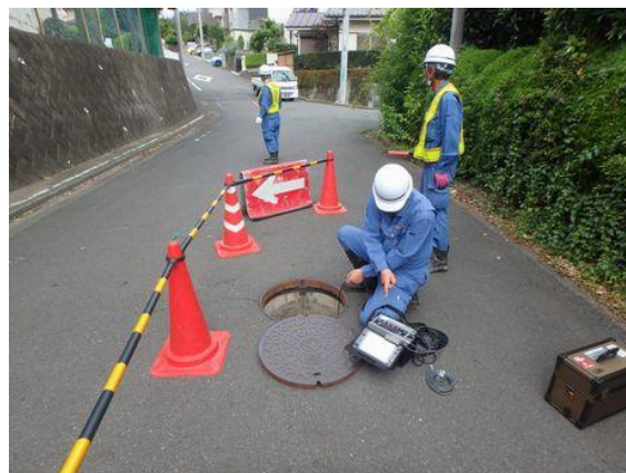
図8 点検・調査状況
