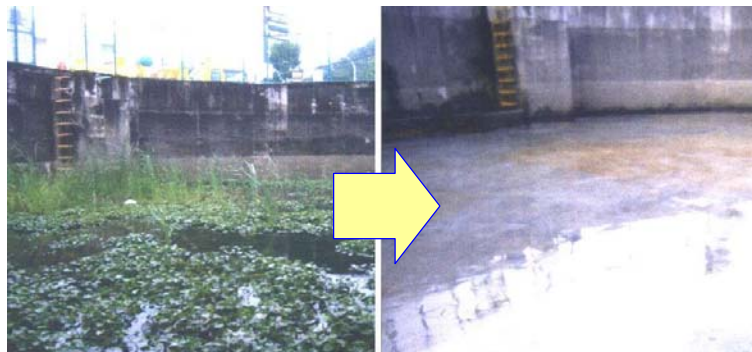
調整池の土砂の浚渫(しゅんせつ)
