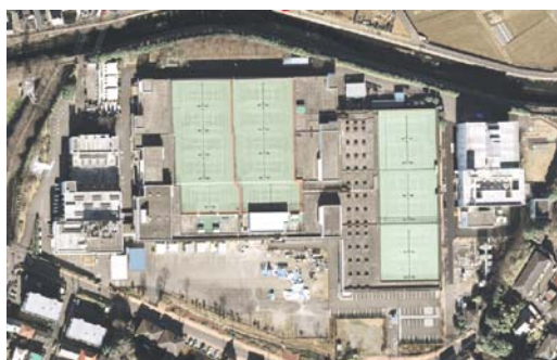
成瀬クリーンセンター 1977(昭和52)年10月 稼動
