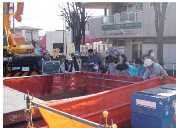
雨水管工事の現場見学の様子
