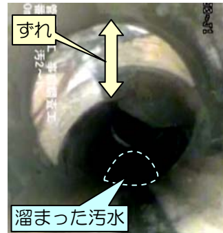
テレビカメラ調査で判明した異常箇所（左の写真は根の侵入、右は管のずれ）
