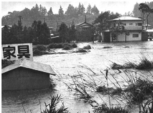
集中豪雨による被害の様子(1972年7月)
