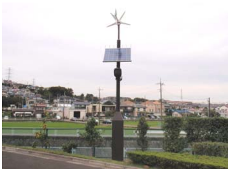
太陽光・風力利用の外灯
