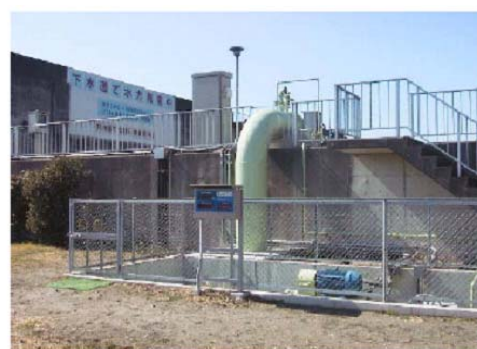
葛西水再生センター（東京都）
