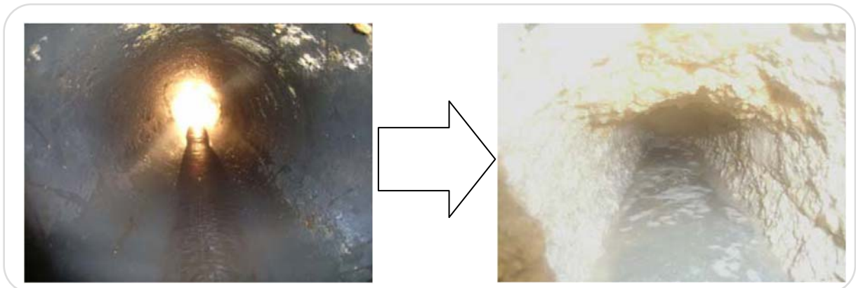
汚水管に油脂が堆積した状態
