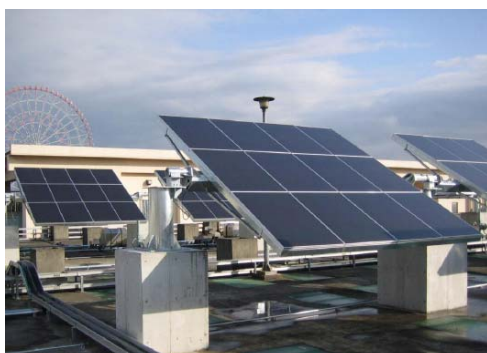
葛西水再生センター（東京都）
