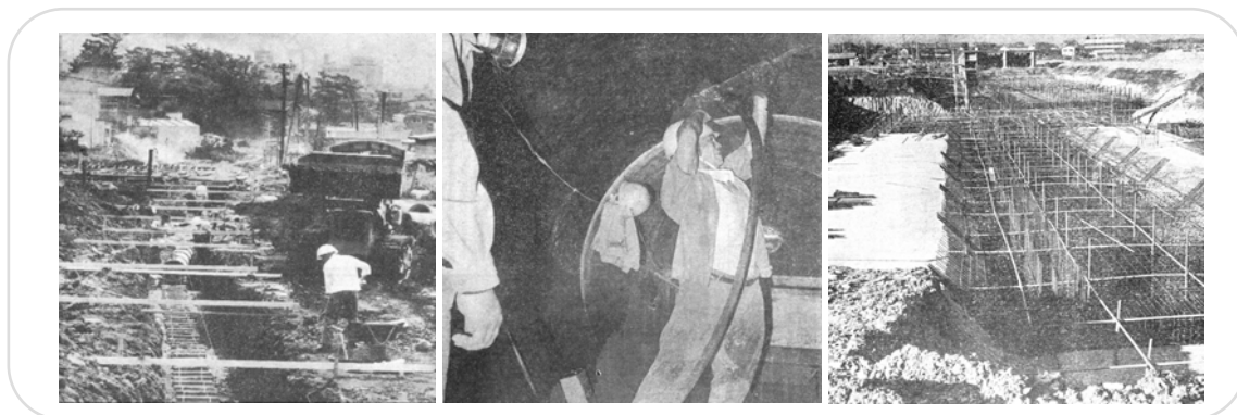
污水整備が本格化した 1970 年代の工事の様子 (左と中央の写真は污水管工事の様子、右は工事中の成瀬クリーンセンター)
