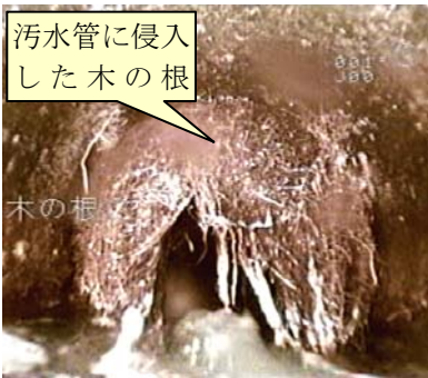
テレビカメラ調査で判明した異常箇所（左の写真は根の侵入、右は管のずれ）
