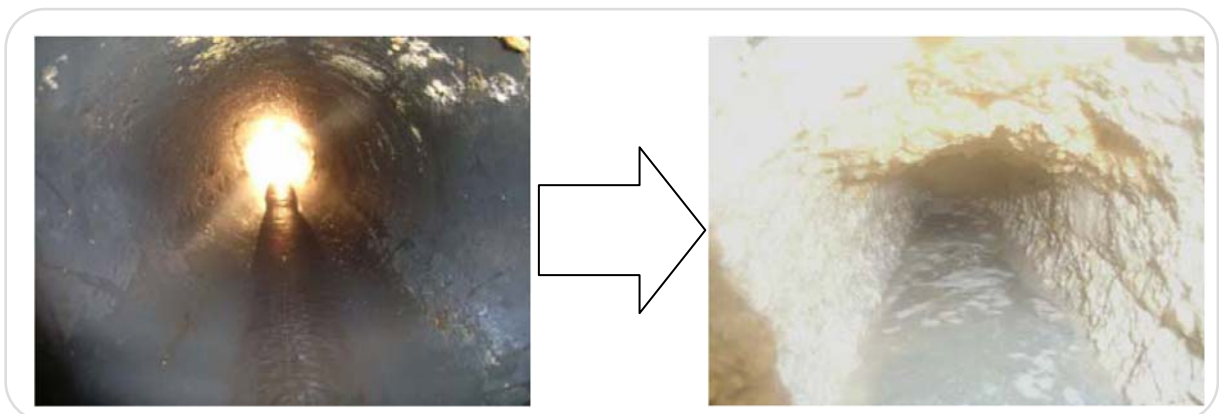
汚水管に油脂が堆積した状態
