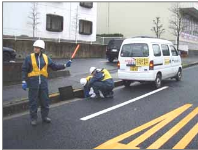
道路側溝の清掃
