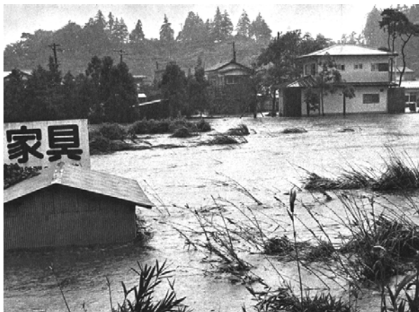
集中豪雨による被害の様子(1972年7月)
