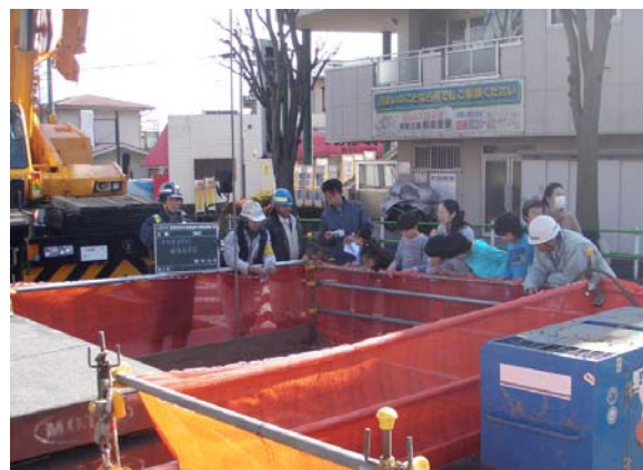
雨水管工事の現場見学の様子
