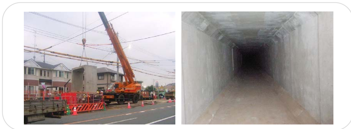
小山地区で整備中の雨水管（口径 2,600mm×2,600mm）
