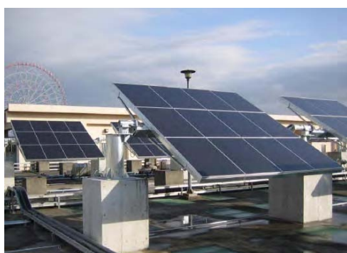
葛西水再生センター（東京都）
