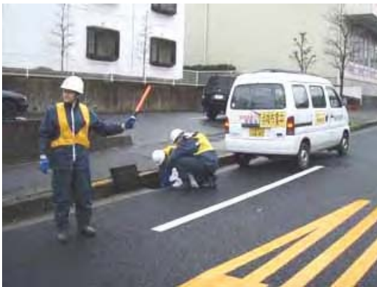
道路側溝の清掃
