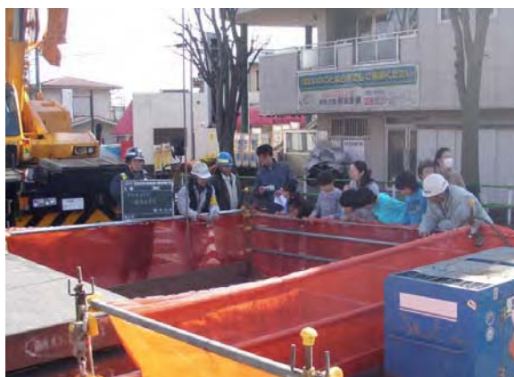
雨水管工事の現場見学の様子
