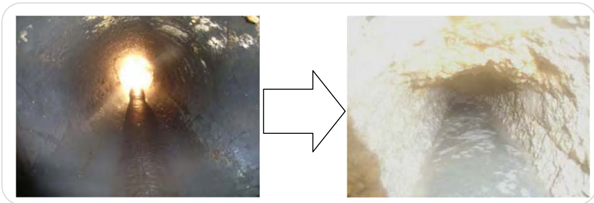
污水管に油脂が堆積した状態
