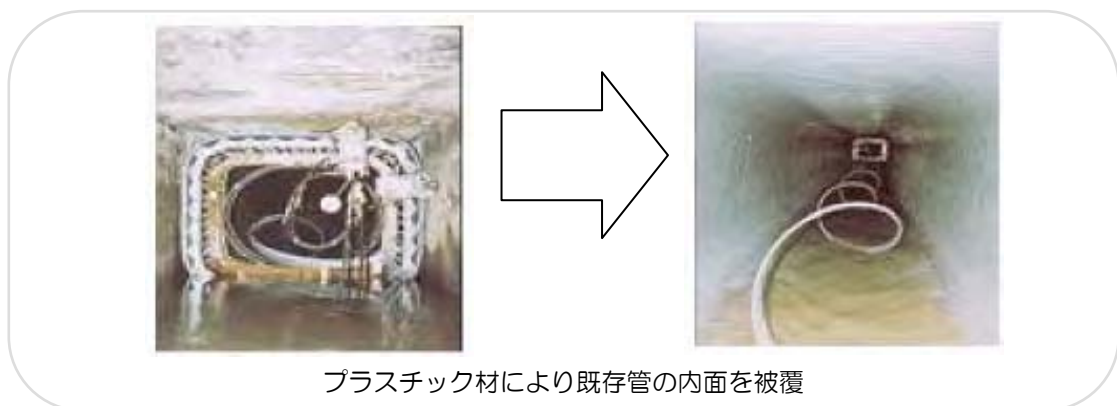
図 47 施設の延命化（更生工法の施工事例）
