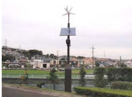
太陽光・風力利用の外灯
