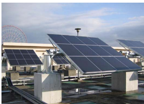
葛西水再生センター（東京都）
