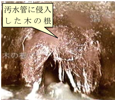
テレビカメラ調査で判明した異常箇所（左の写真は根の侵入、右は管のずれ）
