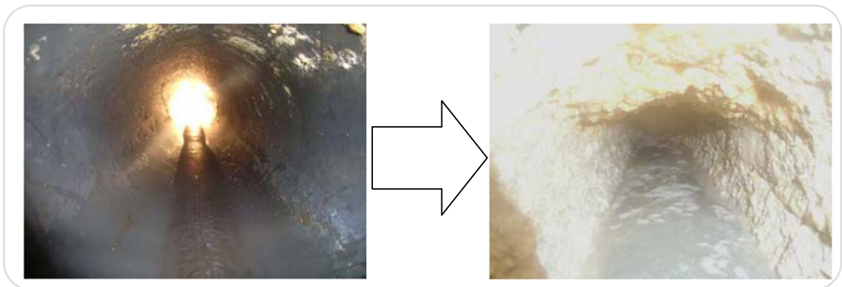
污水管に油脂が堆積した状態
