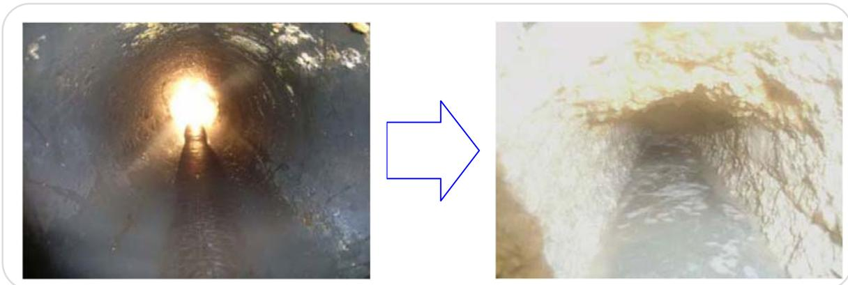
污水管に油脂が堆積した状態
