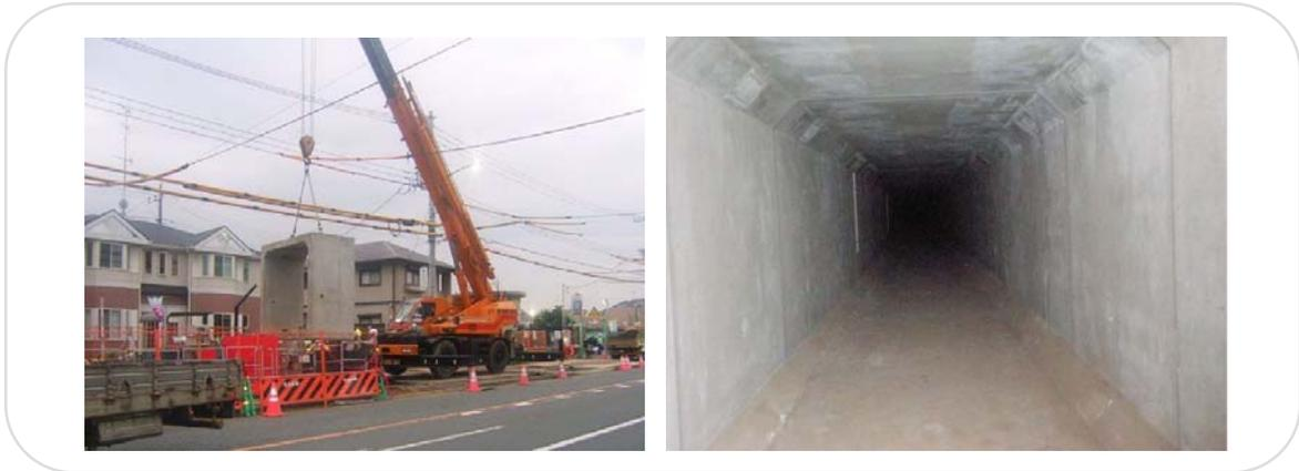
小山地区で整備中の雨水管（寸法 2,600mm×2,600mm）
