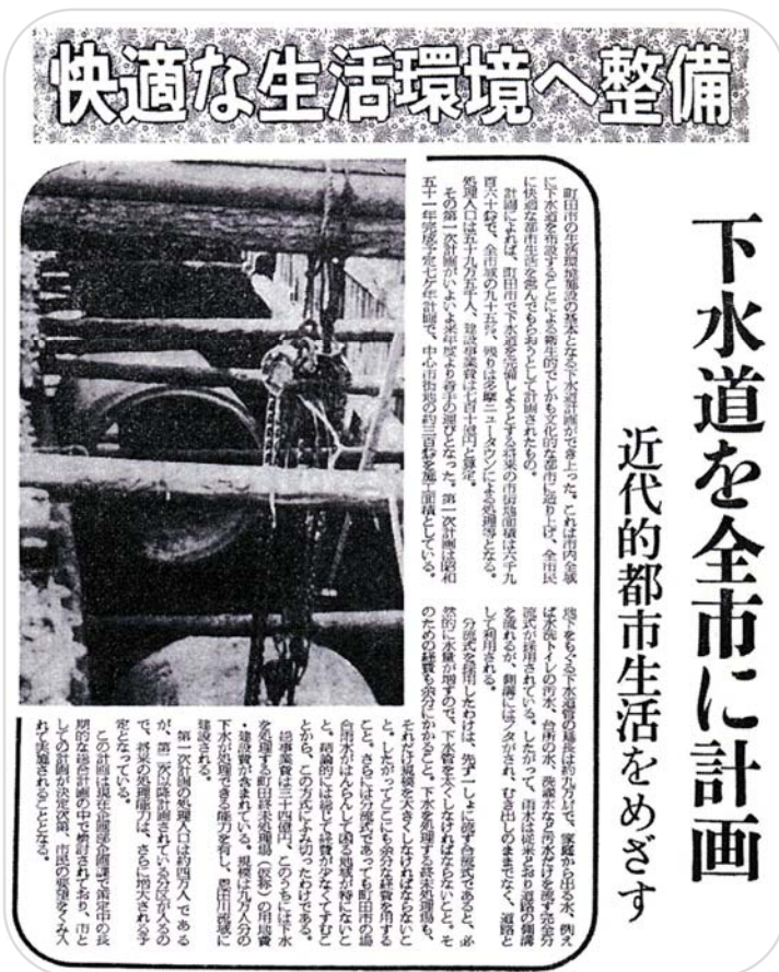
当時の下水道工事の様子 広報まちだ 1969年7月20日号
