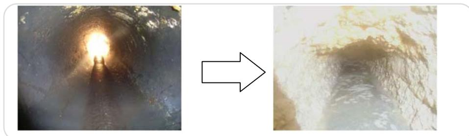
図 4 汚水管に油脂が堆積した状態
