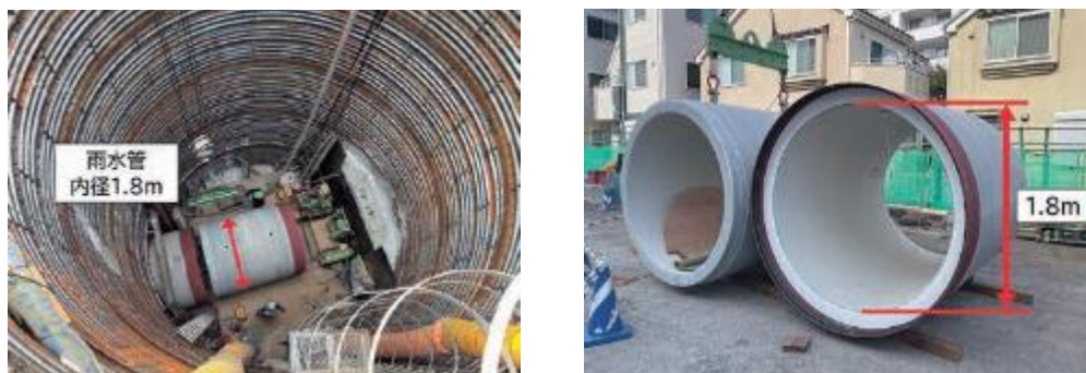
(大口径推進管：内径1.8m) 図6-8 浸水対策として行う雨水管整備工事
