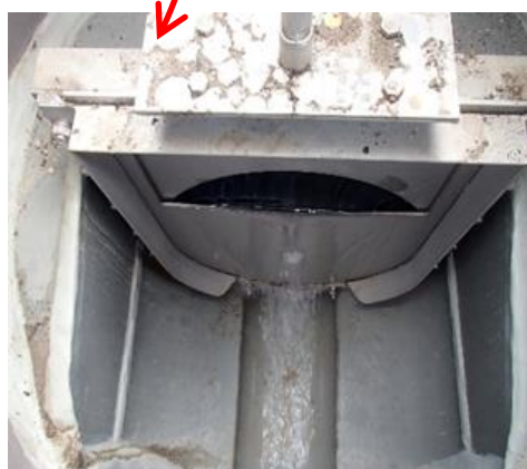
図 6-19 マンホールトイレの仕組み（イメージ図）
