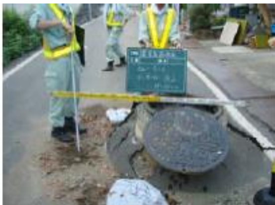
図 6-16 液状化によるマンホール浮上状況（写真）
