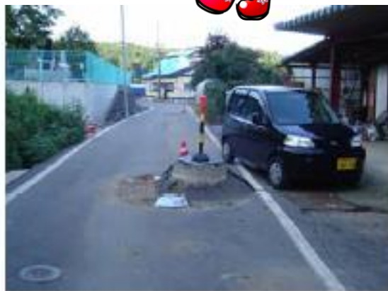
図 6-16 液状化によるマンホール浮上状況（写真）
