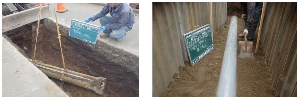
図 6-30 下水道管の布設替え工事例（写真）
