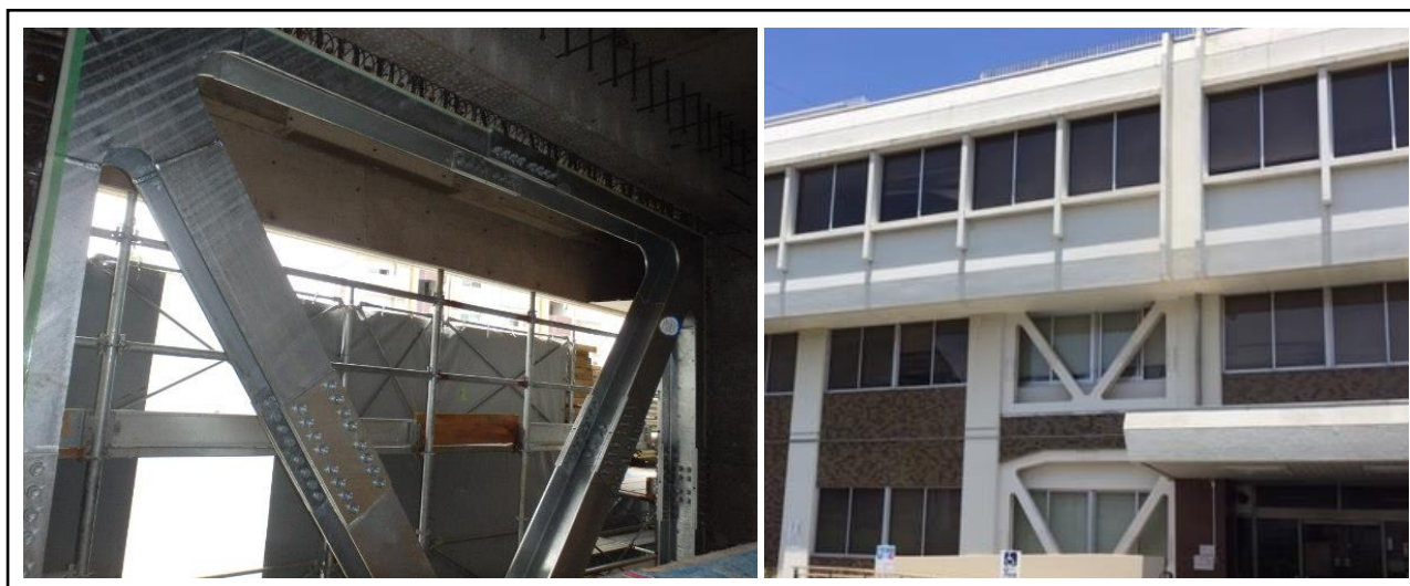
図 6-13 耐震補強工事中の建物（写真左）及び耐震化工事完了後の建物（写真右）
