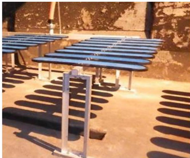
図 6-6 成瀬クリーンセンターの高効率散気装置（写真）
