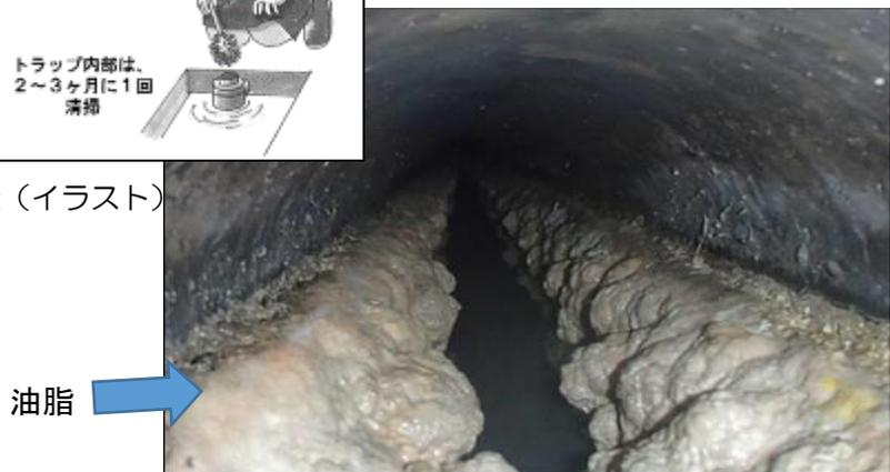
図 6-4 油脂がたまった下水道管の内部（写真）
