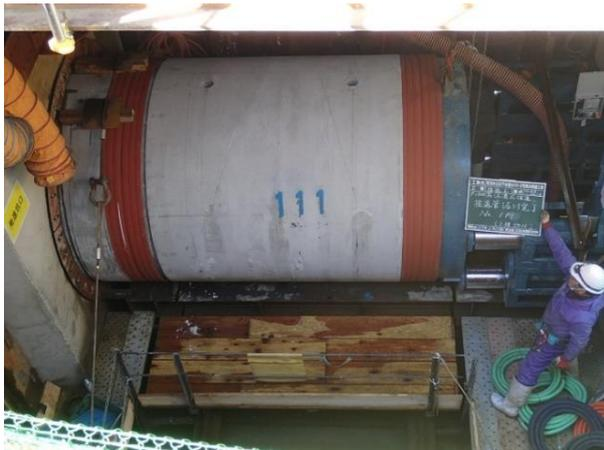
(大口径推進管：内径 2000mm)
