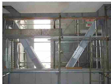
図8. 耐震プレス補強
