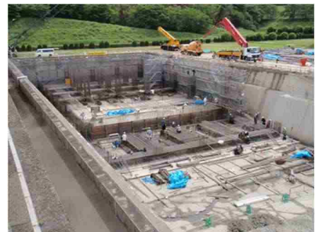
図3. 水処理棟増設工事 (鶴見川クリーンセンター)
