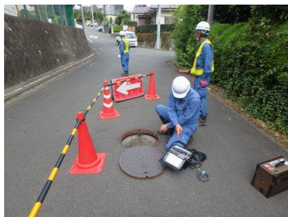
図8 点検・調査状況
