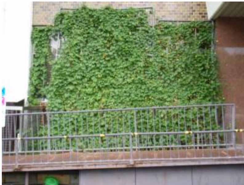
水再生センター水質係事務所
