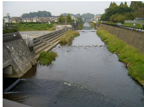
鶴見川（麻生橋付近）
