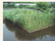
高ヶ坂にある松葉調整池
