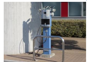
図 市庁舎設置普通充電器
