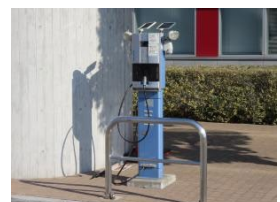
図 市庁舎設置普通充電器 出典：町田市
