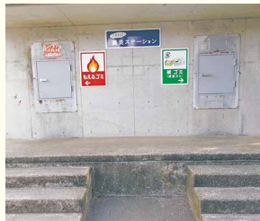
生徒が設置したごみ保管場所
