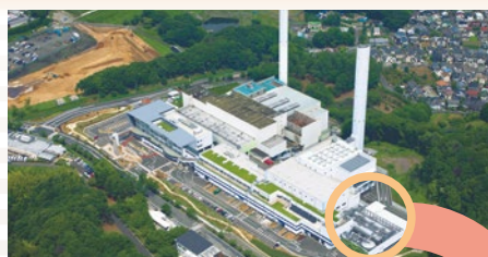
町田市バイオエネルギーセンター
