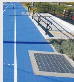
鶴間公園集水桝
