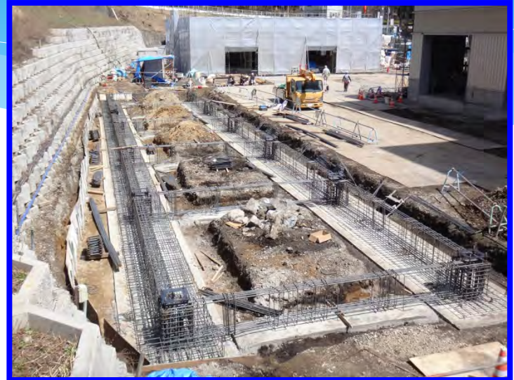
コンクリート工事
