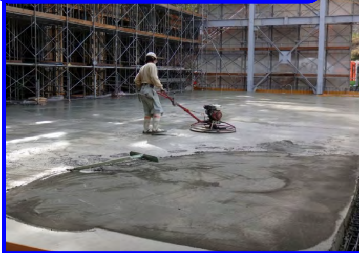
コンクリート打設後 こて仕上げ作業
