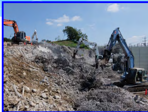
地下解体状況
