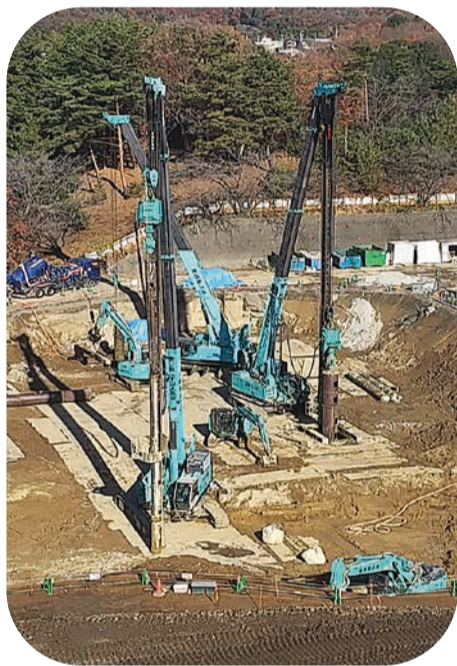
工事の様子 (地中杭の引き抜き作業)
