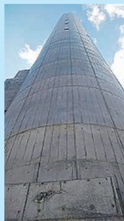
外筒完成 今後は内筒設置と塗装 工事を行います。
