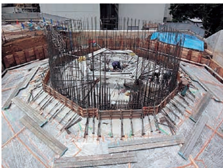
基礎工事 直径22mの基礎（土台）が完成した ところです。
