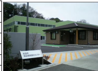
剪定枝資源化センター外観
