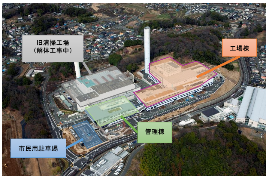
町田市バイオエネルギーセンター 2022年3月時点【稼働中・一部工事中】
