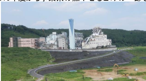
東京たま広域資源循環組合エコセメント化施設
