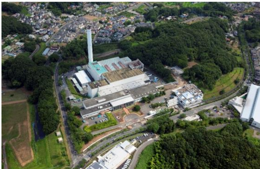
町田リサイクル文化センター 2017年7月時点【工事前】
