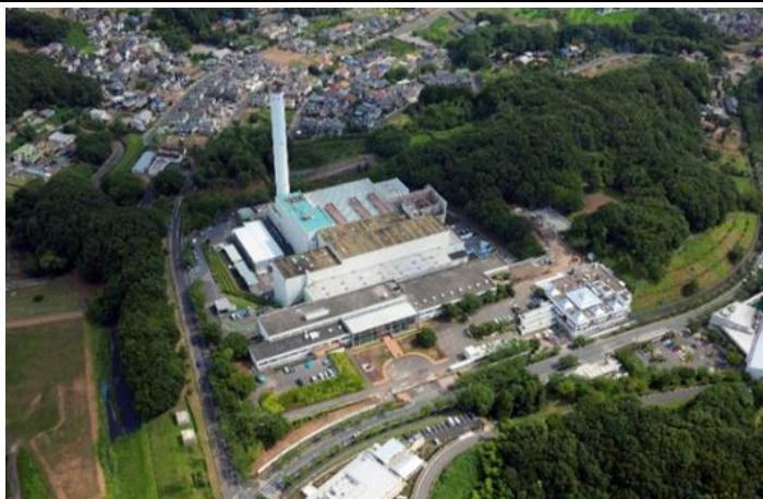
町田リサイクル文化センター 2017 年 7 月時点【工事前】
