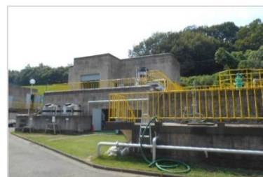
排水浄化センター外観
