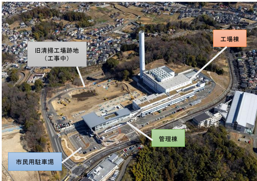
町田市バイオエネルギーセンター 2024 年 3 月時点【稼働中・一部工事中】
