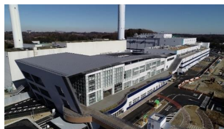
町田市バイオエネルギーセンター
