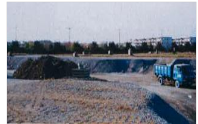
町田市最終処分場
