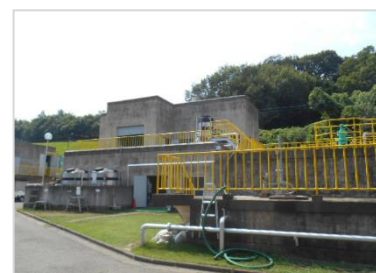
排水浄化センター外観
