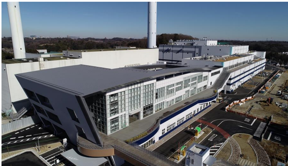
町田市バイオエネルギーセンター外観
