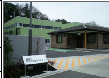
剪定枝資源化センター外観
