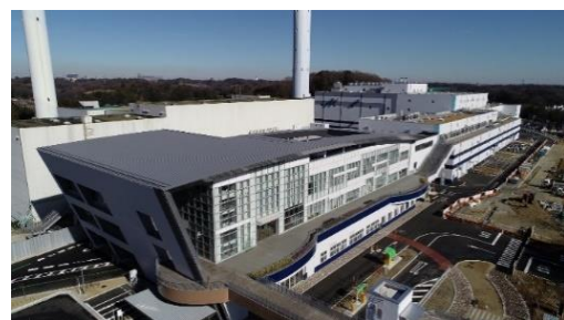
町田市バイオエネルギーセンター
