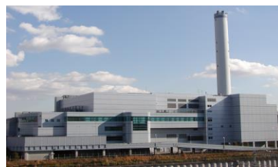
多摩ニュータウン環境組合多摩清掃工場
