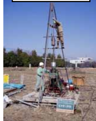
標準貫入試験の状況
