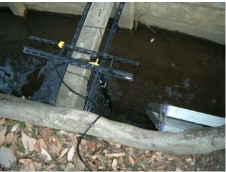
濁度計設置状況
