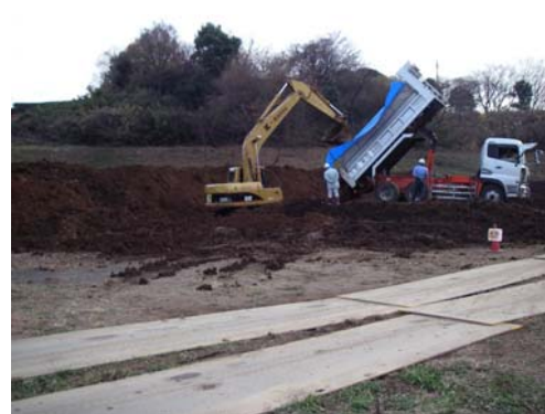
搬入土の確認状況
