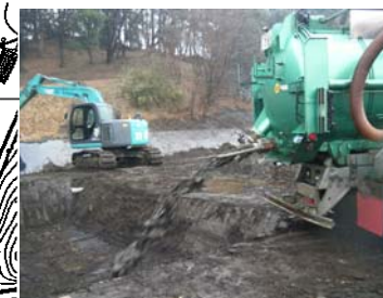
貯留堤内へ汚泥排出
