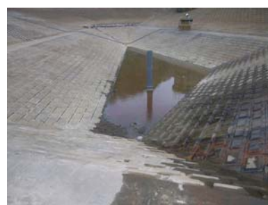
立ち上げ管の補修
