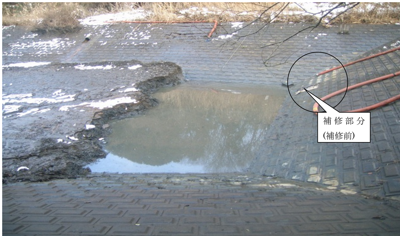
町田市最終処分場 雨水調整池 西側最下部(池の辺側)カド 法面補修状況 (撮影日 上:2010年2月上旬、下:2010年4月14日(水))
