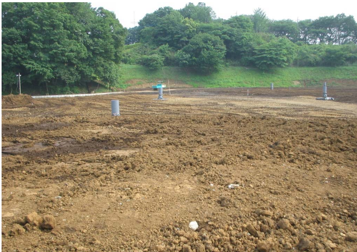
⑦ 池の辺工区・覆土
