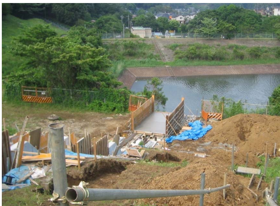
⑥ 階段水路 池の辺→調整池
