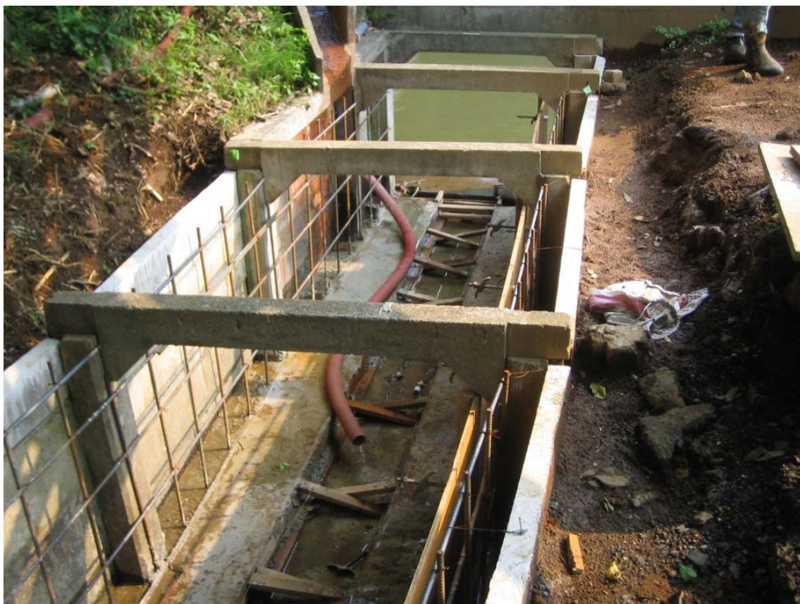
⑧ 浸出水放流水路
