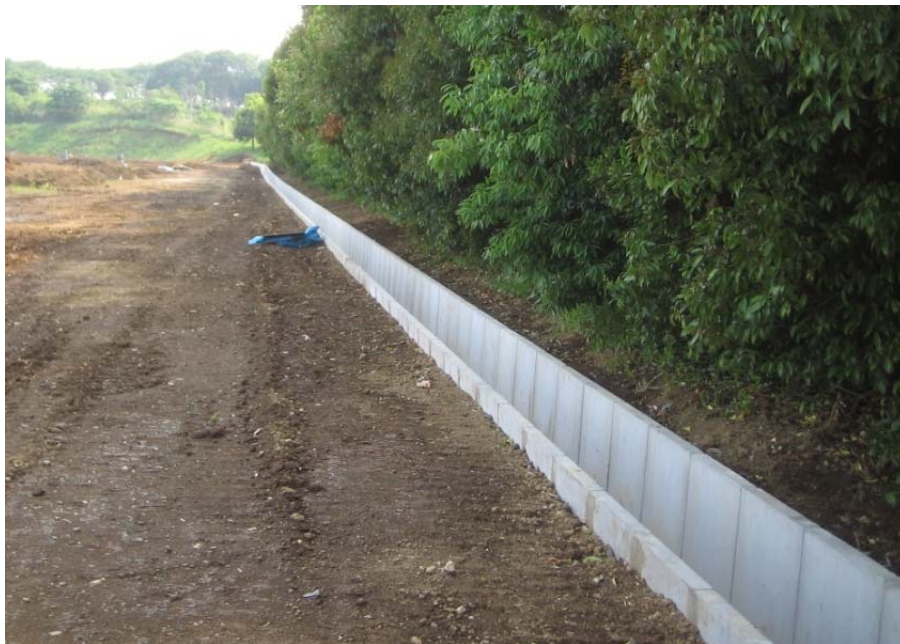
⑤ 池の辺 外周水路・団地側
