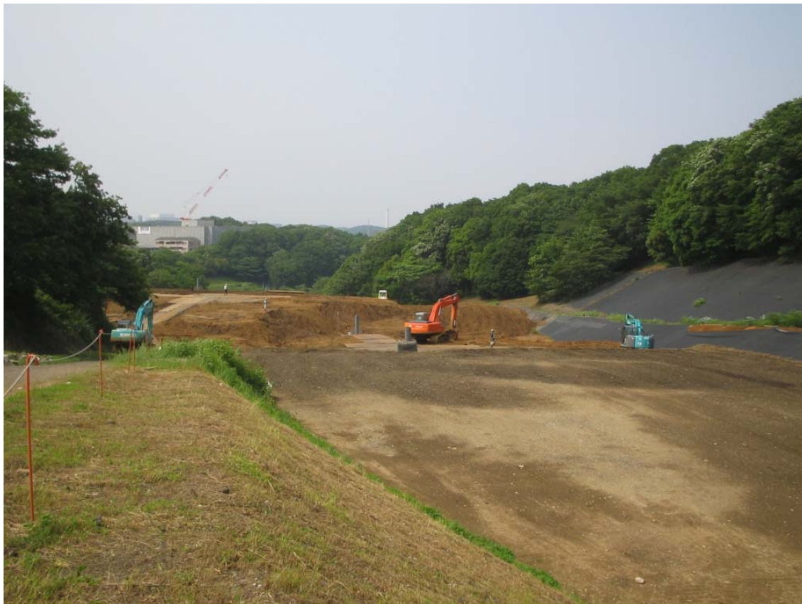
① 峠谷全景・入り口から見下ろす
